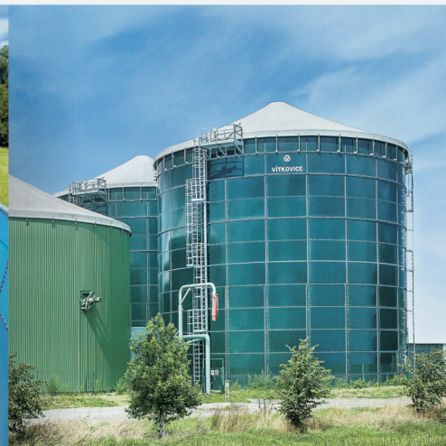
БИОГАЗОВЫЕ СТАНЦИИ, ПЕРЕРАБОТКА ЖИДКИХ ОТХОДОВ
